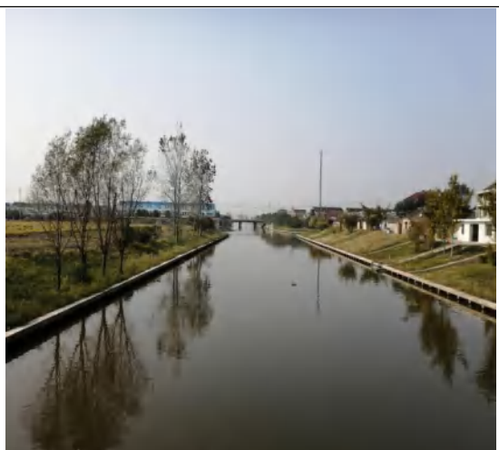
河坡撒播草籽 3
