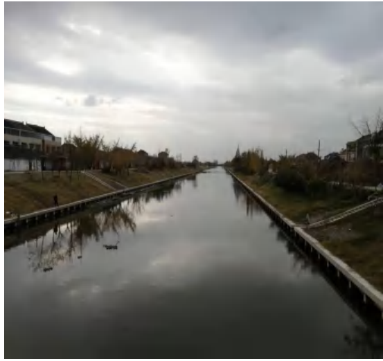
河坡撒播草籽 2
